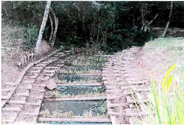
Fig. 4.2. Córrego 2: Implantação das estruturas de engenharia natural
