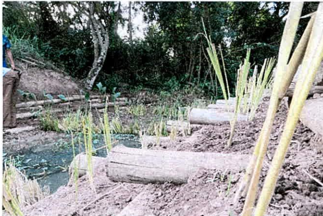
Fig. 4.3 Vista das estruturas de engenharia natural
