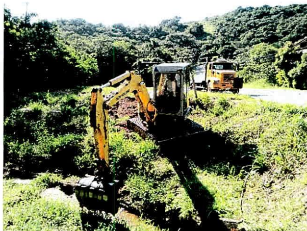
Fig.1.1. Imagens da limpeza do córrego 1
