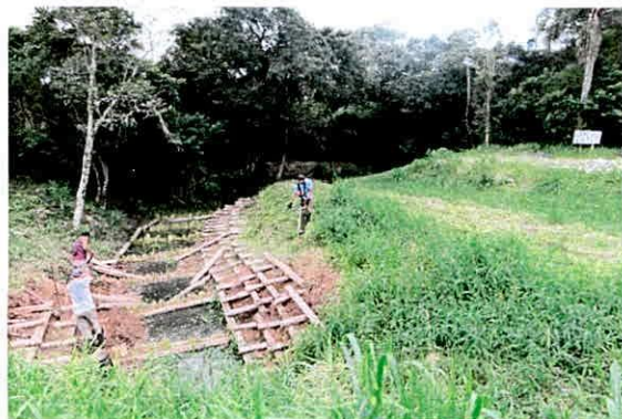
Fig. 5.3. Imagens de implantação das estruturas de engenharia natural;
