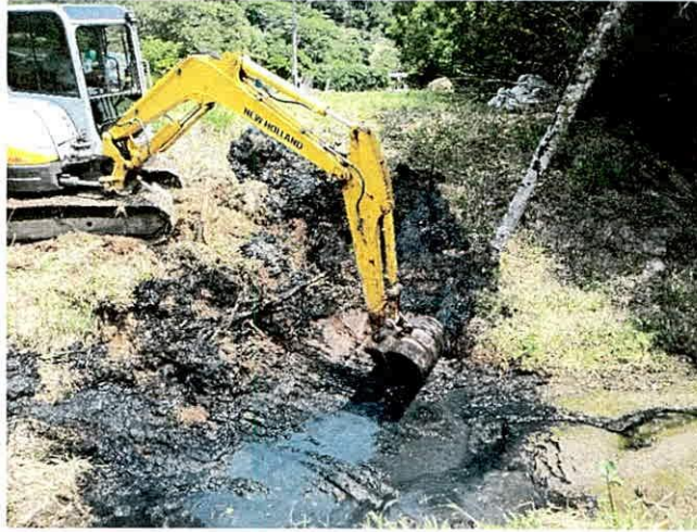
Fig.2.3 Limpeza do córrego 2
