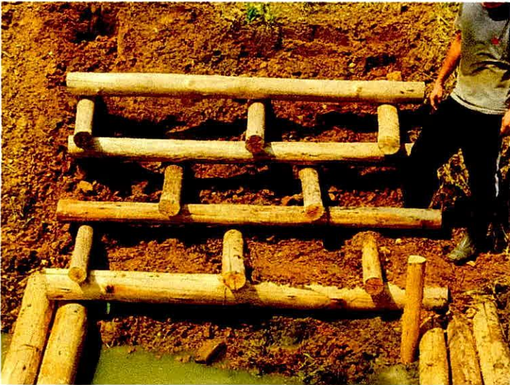
Fig.4.4 estruturas de Engenharia Natural
