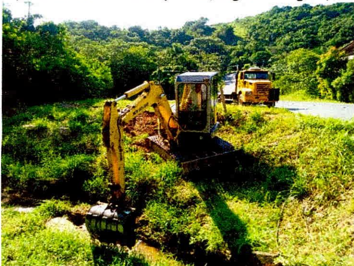
Fig.1.1. Imagens da limpeza do córrego 1
