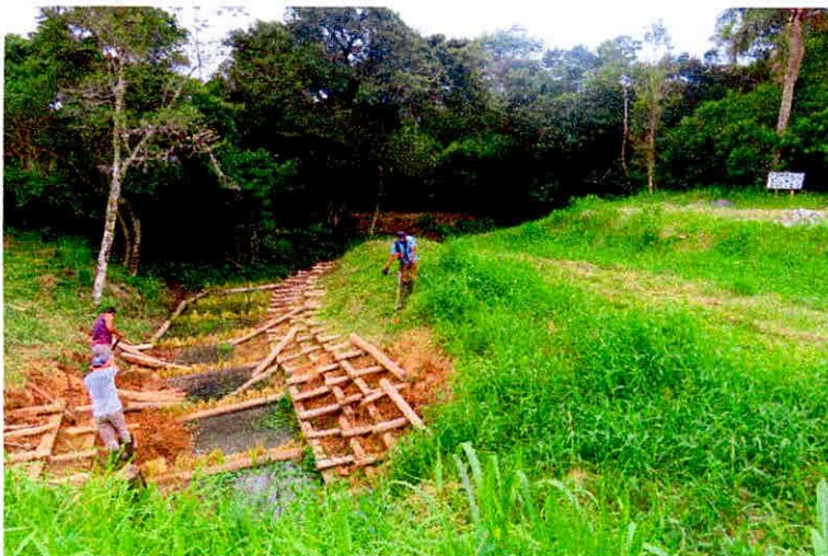
Fig. 5.3. Imagens de implantação das estruturas de engenharia natural; Limpeza, roçagem e plantio de espécies
