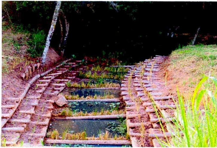
Fig. 4.2. Córrego 2: Implantação das estruturas de engenharia natural
