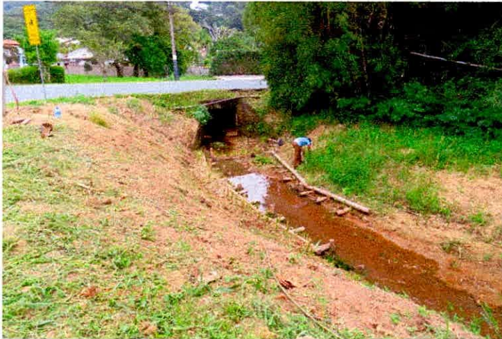
Fig.3.1. Imagens da implantação das estruturas verdes do córrego 1
