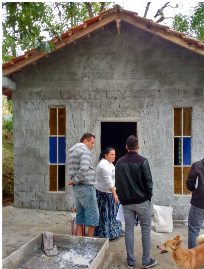
sala nova que está sendo construída
