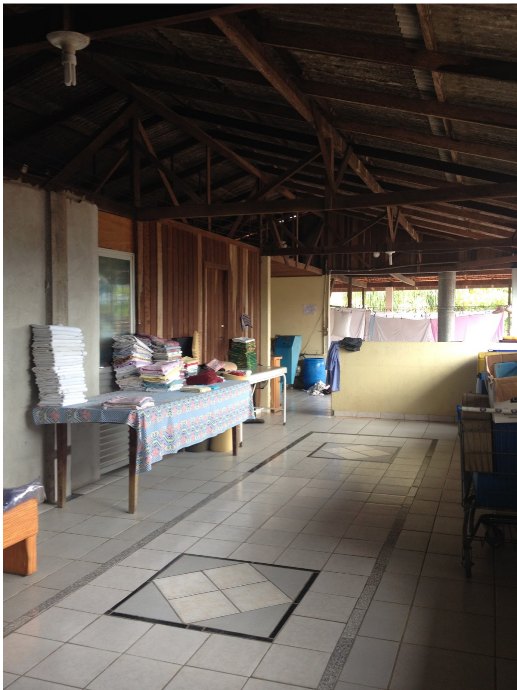
Imagem 03 - Piso superior: lavanderia.
