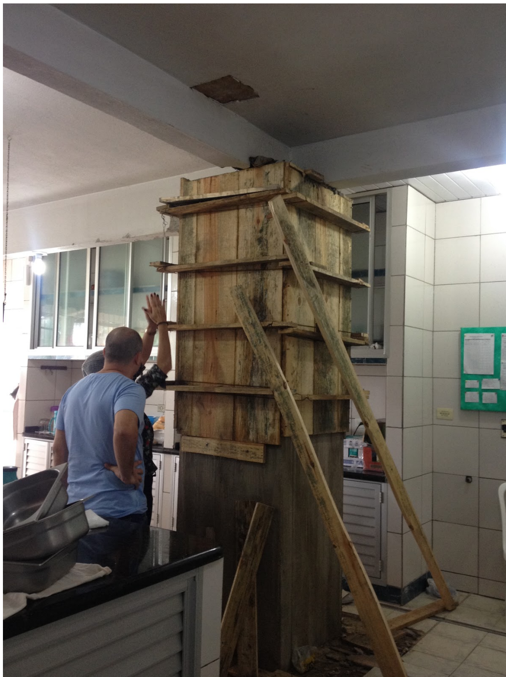
Imagem 01 - Viga realizada na cozinha.
