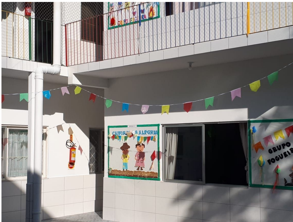
Imagem 10 - Painéis concluídos, Unidade I - Vianna de Carvalho.
