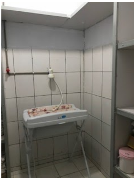
Imagem 06 - Área que será construído fraldário - Vianna de Carvalho.
