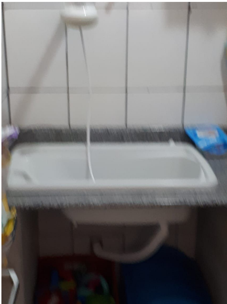
Imagem 07 - Fraldário concluído instalação do mármore e banheira, na Unidade I - Vianna de Carvalho.
