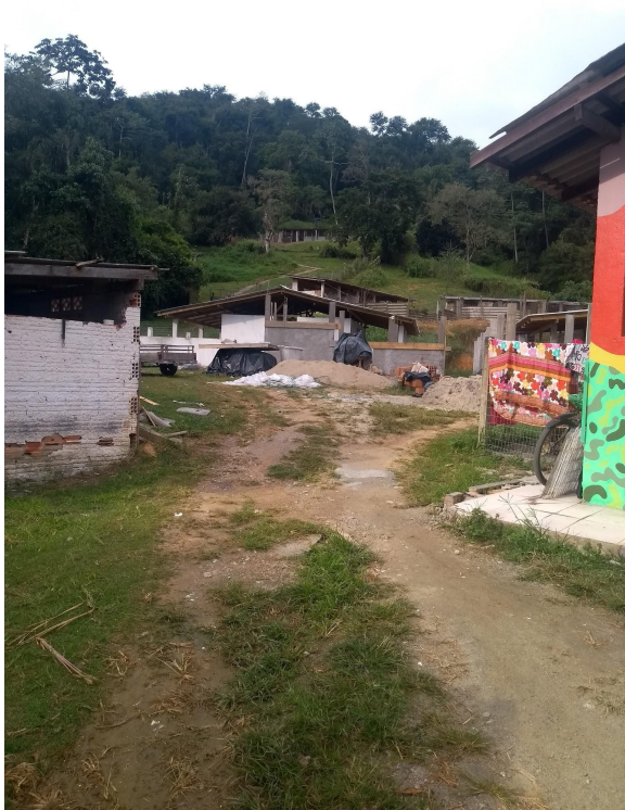
baias em construção
