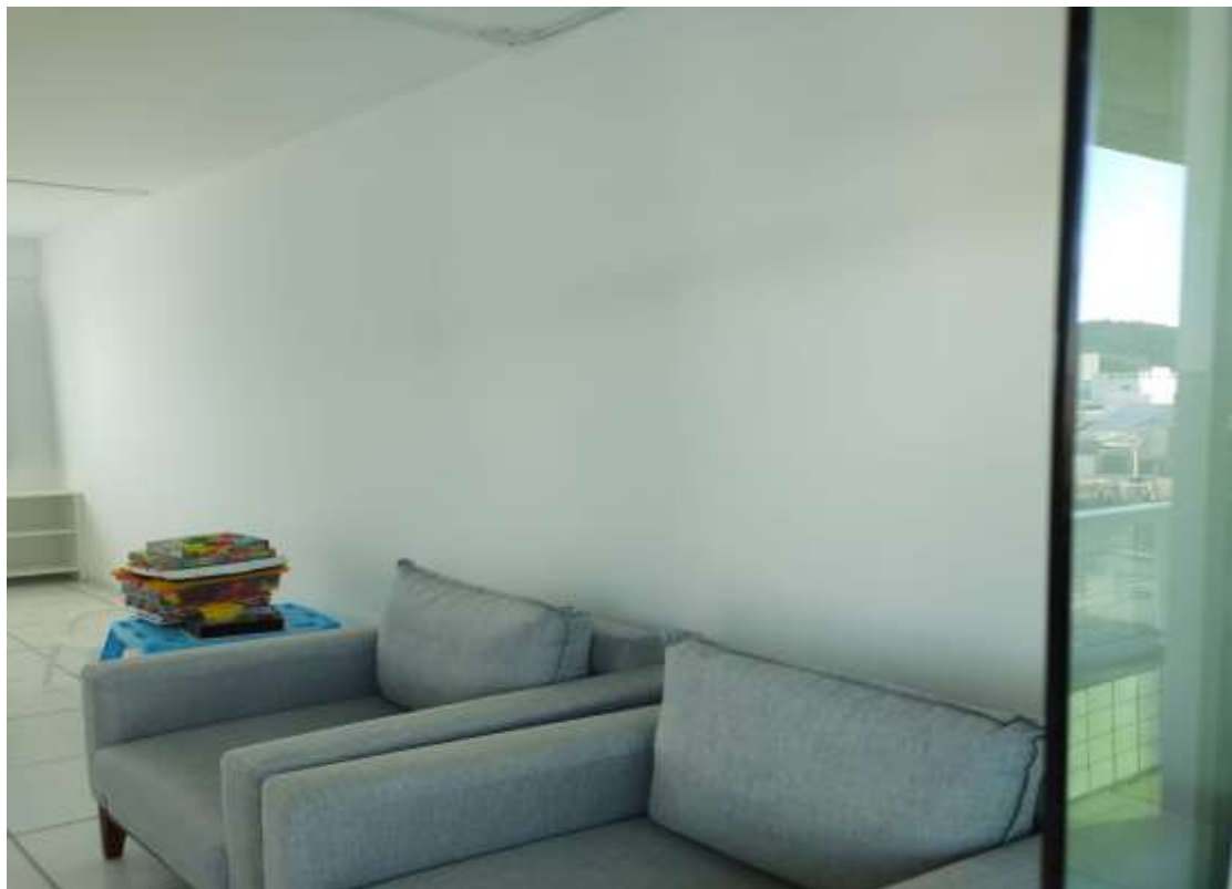
Divisórias Dry Wal/gesso
