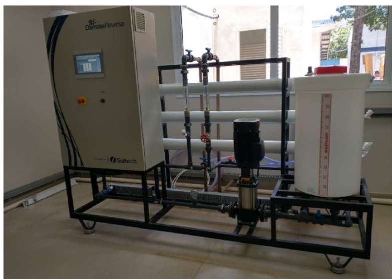
Imagem: sistema de tratamento de água
