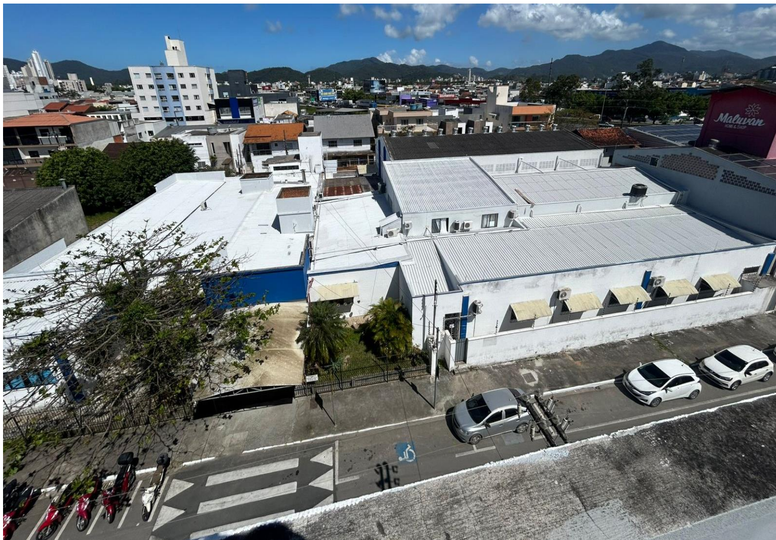
Imagem 3 Telhado Geral - Sede APAE
