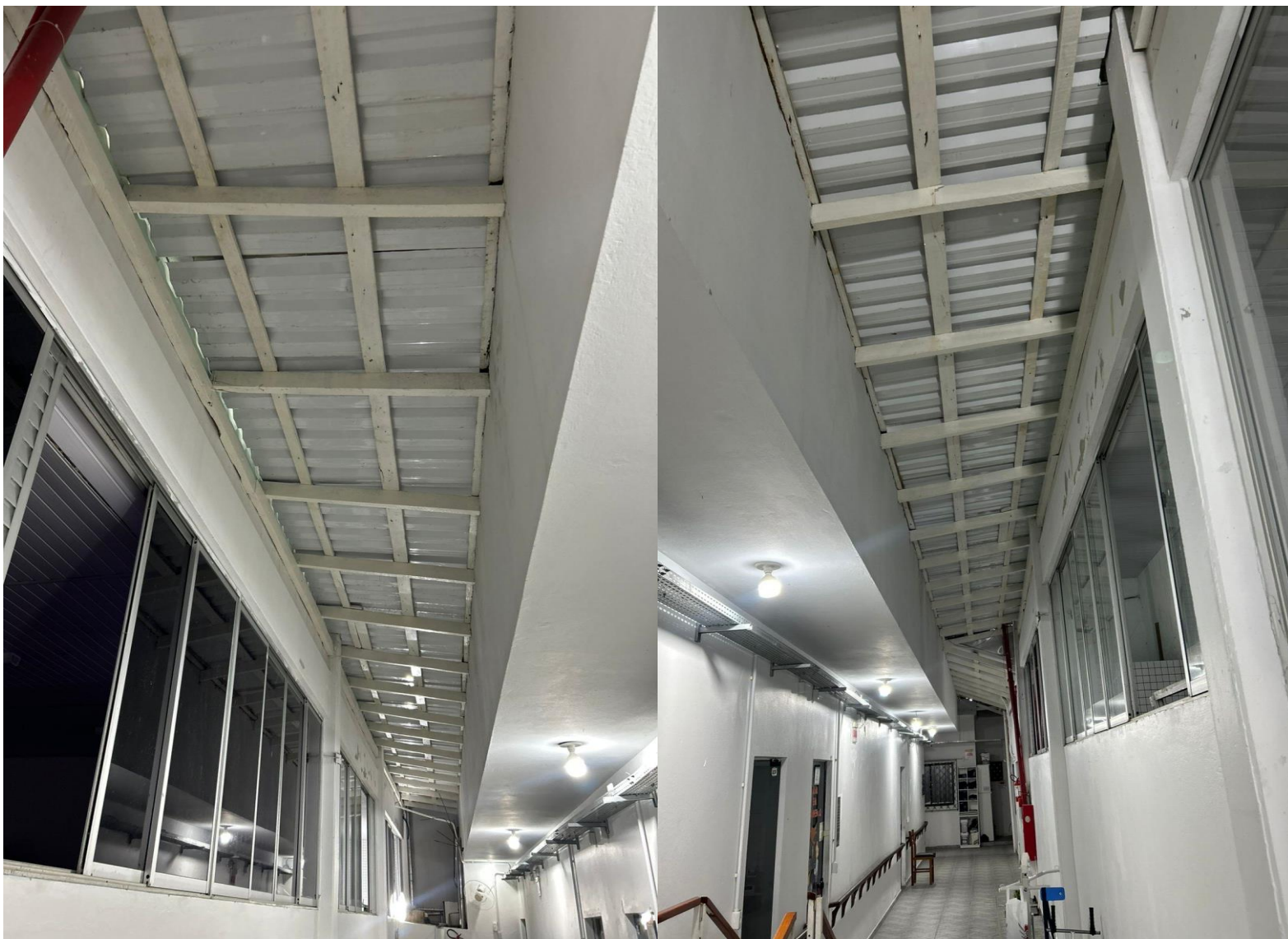
Imagem 1 Troca do telhado corredor da fisio por telha sanduiche
